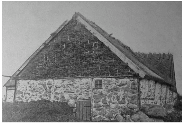
T.v. En variant med lerstakar som har halmrep glest invirat efter att stakarna satts, jämför med citat från 1817 nedan. Foto från återuppbyggnaden av Dörrödshuset på Frilandsmuseet i Kongens Lyngby. 32 T.h. Holmana St Olof sn. Albo hd. Korsverk med fältsten i facken. Efter Nilsson 1903.
