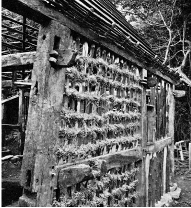
T.v. En variant med lerstakar som har halmrep glest invirat efter att stakarna satts, jämför med citat från 1817 nedan. Foto från återuppbyggnaden av Dörrödshuset på Frilandsmuseet i Kongens Lyngby. 32 T.h. Holmana St Olof sn. Albo hd. Korsverk med fältsten i facken. Efter Nilsson 1903.
