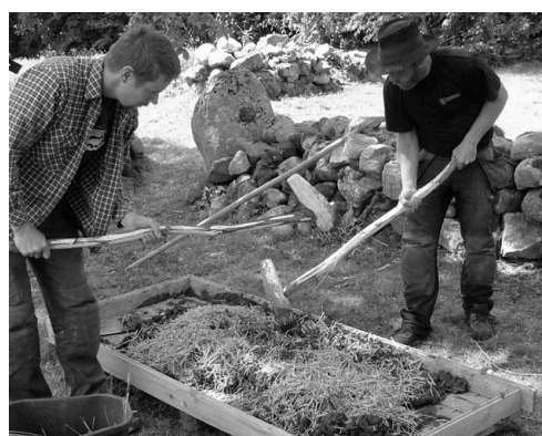
T.v. I vänstra laven ältat originalbruk i högra nyuppgrävd ältad lera. T.h. Först när leran var väl ältad tillförde vi den blötade och hackade halmen. Ältarna är Janne Sjöblom och Olof Andersson. Foto t.h. Nils-Erik Andersson.
