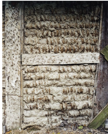
Bilder från hus i Gringelstad, Norra Åsums s.n. T.v. i förgrunden ligger en kort lerstake med välgjord tapp till hål i undersida lejd/lösholt, nedkant spetsad längsledes för att passa i ränna och fjäll är huggna för att leran ska fästa. T.h. Vissa fack hade horisontella trästakar med glest virat halmrep. Istället för hål och ränna hade här lister spikats på stolparna på samma vis som på falskt skiftesverk.
