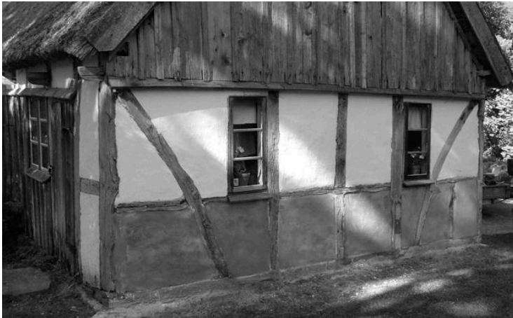
Agusastugans gavel där de undre facken restaurerades. De två första facken till vänster har ren lerputs sen ökar kalkmängden till att det sista facket enbart har kalkputs. Foto Nils-Erik Andersson.
