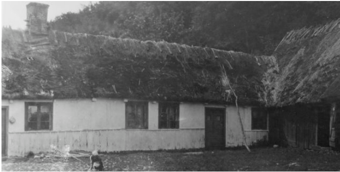
T.v. Vittad lining upp till fönstren. Lining under fönstren har ibland lagts med liggande brädor. Andrarums s.n. foto Gotthard Gustavsson, LUF:s arkiv. T.h. Lining som går upp till fönstrens överkant. Agusastugan Albo härad.
