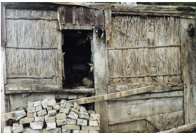
Bild från samma hus där falskt skiftesverk utvändigt klätts med vass som hölls fast med påspikade hasselkäppar.
