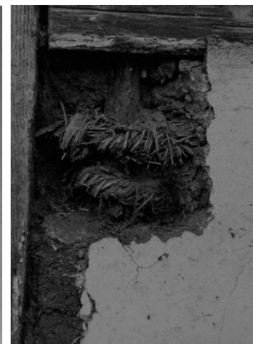
T.v. Brödåkra, Ysby, Halland. Efter Sandklef 1953:61. Vägg med horisontella stakar med virat halmrep av den typ som i Skåne kallas för klibbstakar och som även påträffats i innertakskonstruktioner av undertecknad. Mitt. Foto på dylik klibbstake i korsverk på gård i Goentorps by, Kvidinge sn. LUF:s arkiv. T.h. Detalj av annat fack på samma gård i Goentorp som istället har sprödavägg av vidjor som ej klyvts, LUF:s arkiv.
