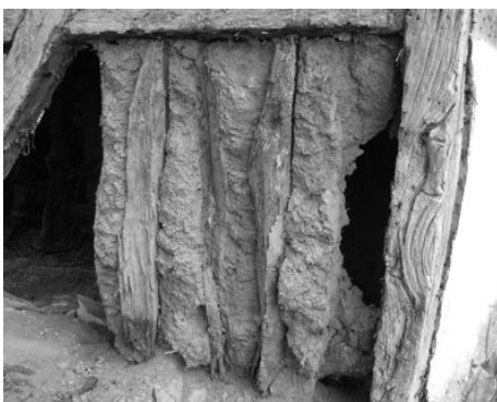
Bild t.v. visar klyvda bokstakar som är tillspetsade i ovanändan. I lösholtet är borrarat hål för att fixera stakarna. Nederändan står på stenfoten då fotträ saknas. Bild t.h. Hög med nyklivna bokstakar som fick ersätta de uttjänta.
