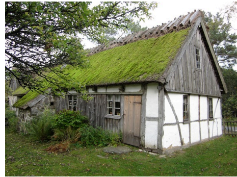
T.v. Vittad lining upp till fönstren. Lining under fönstren har ibland lagts med liggande brädor. Andrarums s.n. foto Gotthard Gustavsson, LUF:s arkiv. T.h. Lining som går upp till fönstrens överkant. Agusastugan Albo härad.
