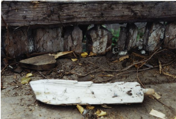
Bilder från hus i Gringelstad, Norra Åsums s.n. T.v. i förgrunden ligger en kort lerstake med välgjord tapp till hål i undersida lejd/lösholt, nedkant spetsad längsledes för att passa i ränna och fjäll är huggna för att leran ska fästa. T.h. Vissa fack hade horisontella trästakar med glest virat halmrep. Istället för hål och ränna hade här lister spikats på stolparna på samma vis som på falskt skiftesverk.
