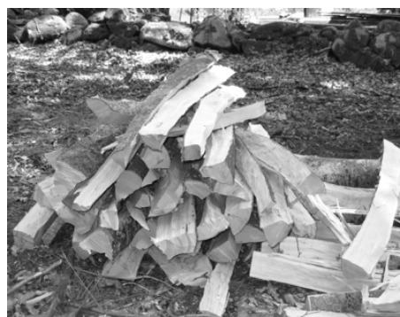
Bild t.v. visar klyvda bokstakar som är tillspetsade i ovanändan. I lösholtet är borrarat hål för att fixera stakarna. Nederändan står på stenfoten då fotträ saknas. Bild t.h. Hög med nyklivna bokstakar som fick ersätta de uttjänta.
