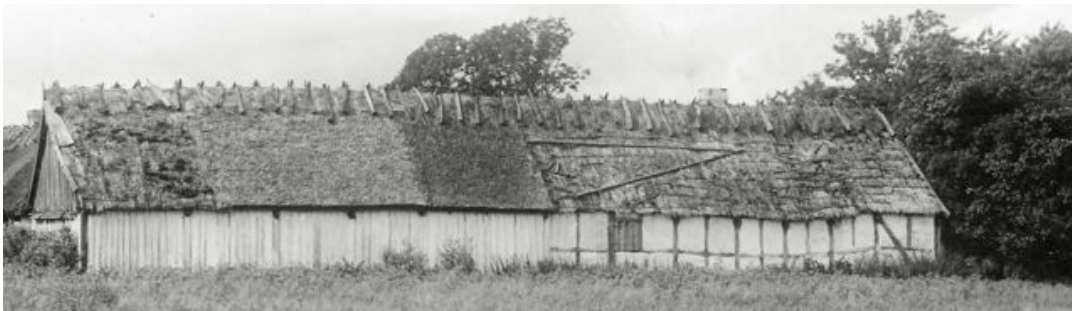
Foto på Bondrumsgårdens västra längas västra långsida. Då fotot togs var halva väggen skyddad med lining som numera är avlägsnad. Notera även att södra gavelröset lutar utåt samt att den har en rejäl vattbräda. Fotot ingår i LUF:s arkiv.
