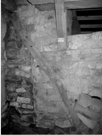
T.v. Korsverksvägg med snedstyva och fackutfyllnad i form av otuktad sten, Gamlegårdsvägen, Alunbruket, Christinehov. T.h. Ett fack på Bondrumsgårdens hölada återuppbyggs med nyklyvda bokstakar som står direkt på stenfoten och uppåt är inträdda i hål på löshultets undersida.
