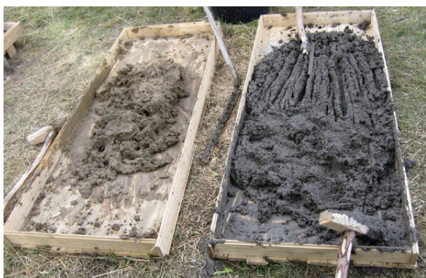
T.v. I vänstra laven ältat originalbruk i högra nyuppgrävd ältad lera. T.h. Först när leran var väl ältad tillförde vi den blötade och hackade halmen. Ältarna är Janne Sjöblom och Olof Andersson. Foto t.h. Nils-Erik Andersson.
