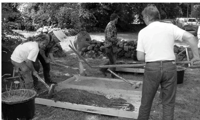
I laven närmast bearbetar Henrik Sundahl och Kenneth Olsson nytt lerbruk med lerklubba och lerpiska. I laven bakom krossar Ingmar Melin gammalt lerbruk, från de fack som ska restaureras, som ska återanvändas. I nedre hörnet t.v. står en balja med blötlagd halm som ska användas som armering i bruket. Foto Nils-Erik Andersson.
