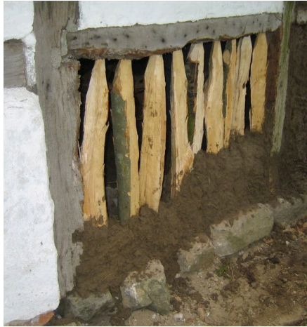
T.v. Korsverksvägg med snedstyva och fackutfyllnad i form av otuktad sten, Gamlegårdsvägen, Alunbruket, Christinehov. T.h. Ett fack på Bondrumsgårdens hölada återuppbyggs med nyklyvda bokstakar som står direkt på stenfoten och uppåt är inträdda i hål på löshultets undersida.
