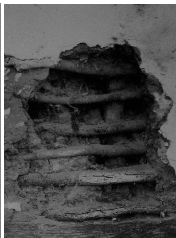
T.v. Brödåkra, Ysby, Halland. Efter Sandklef 1953:61. Vägg med horisontella stakar med virat halmrep av den typ som i Skåne kallas för klibbstakar och som även påträffats i innertakskonstruktioner av undertecknad. Mitt. Foto på dylik klibbstake i korsverk på gård i Goentorps by, Kvidinge sn. LUF:s arkiv. T.h. Detalj av annat fack på samma gård i Goentorp som istället har sprödavägg av vidjor som ej klyvts, LUF:s arkiv.
