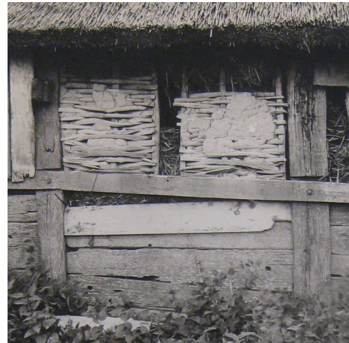
T.v. Björstorp, Brösarps sn., Albo hd. Ovanfacken är såkallade sprödaväggar. Efter Nilsson 1903. T.h. Aleboda, Åhus sn., Sprödaväggar utan kline, de flätade vidjorna är klyvda som på korgar, LUF:s arkiv.
