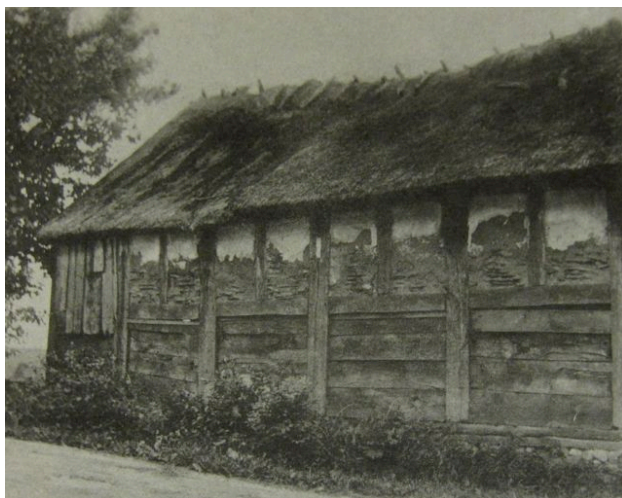
T.v. Björstorp, Brösarps sn., Albo hd. Ovanfacken är såkallade sprödaväggar. Efter Nilsson 1903. T.h. Aleboda, Åhus sn., Sprödaväggar utan kline, de flätade vidjorna är klyvda som på korgar, LUF:s arkiv.
