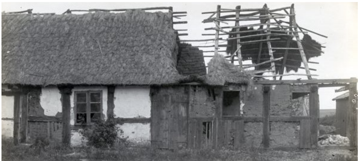
Korsverkshus med lerstakafack, bindbjälkar, eftersom de har skalle är de inga stickbjälkar, försänkta i stolparna under lejden och en skorsten uppmurad av lersten. Foto Mårten Sjöbeck, LUF:s arkiv.
